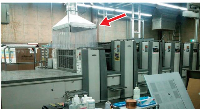
図：局所排気装置の実施例
